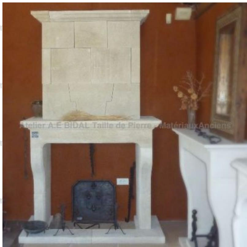
Taillée en nos ateliers de taille de pierre par nos artisans, cette cheminée typiquement provençale est réalisée dans la pierre du Luberon (Esttaillades). Elle présente un socle, des jambages galbés, un linteau sobre, une tablette moulurée, un trumeau géométrique en pierres appareillées et une corniche moulurée. Une création artisanale signée Alain Bidal inspirée des cheminées d'antan.
