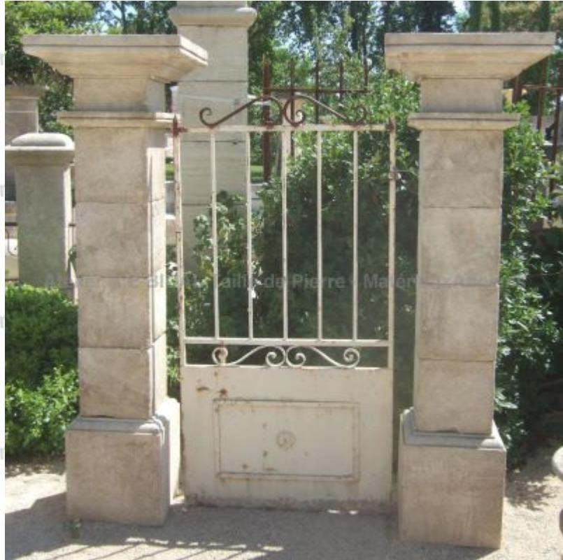
Piliers carrés en pierre de taille (pierre d'Estaillades ou en pierre d'Avy) avec socle carré mono-bloc, fût en plusieurs blocs et large chapiteau plat monolithique. La paire.
