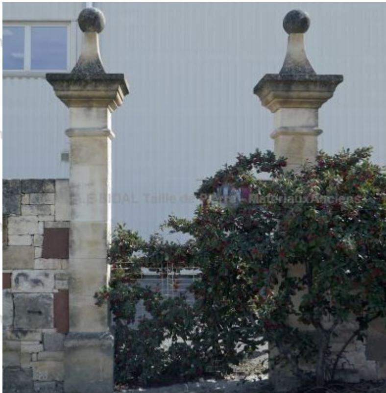
Réalisation artisanale d'une paire de piliers d'entrée pour portail en pierre de taille : Socle mono-bloc carré, fût composé de plusieurs pierres, boudin sculpté sur le haut et superbe chapiteau élancé orné de fines moulures et d'une boule en pierre reposant sur un socle pyramidal.
